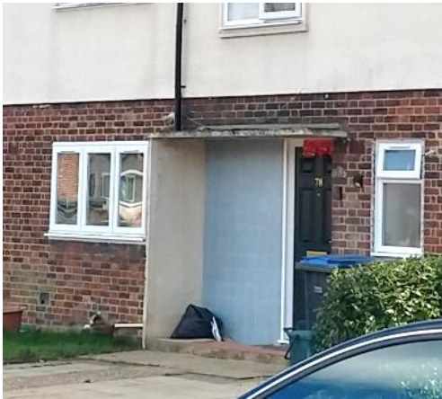
Fig. 7.d.2: Canopy over front door
